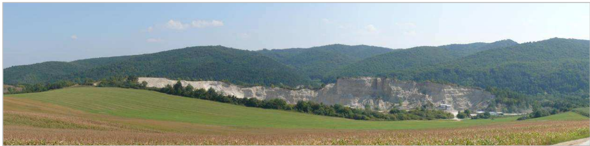
Obr. č. 4: Kameňolom v obvode PPÚ Hradište pod Vrátnom, časť Dolinka
