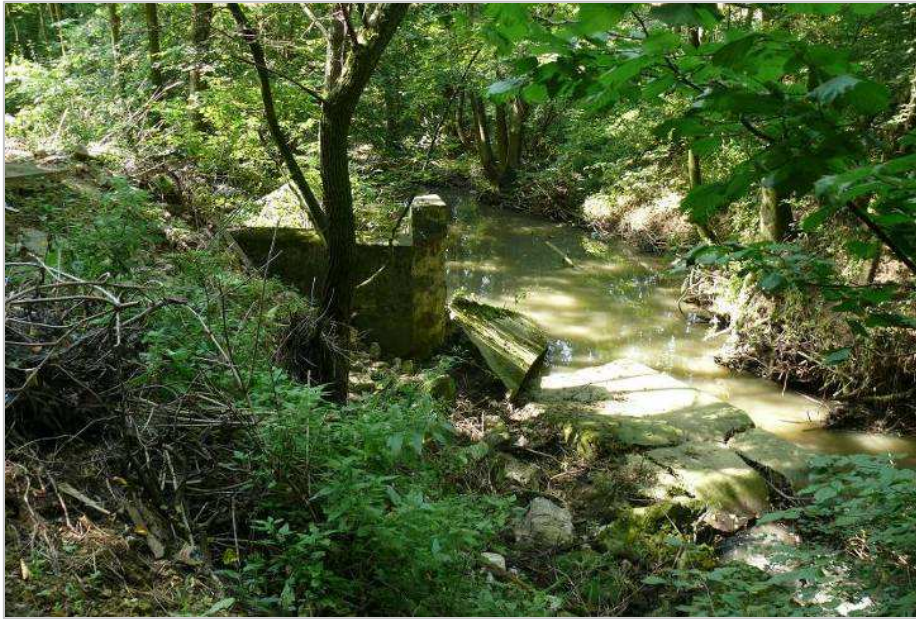
Obr. č. 29: Bariéry antropogénneho pôvodu na Brezovskom potoku
