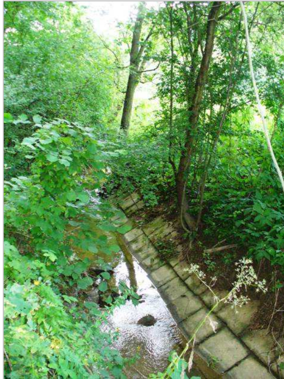
Obr. č. 19: Regulovaná časť Rajtákovho jarku pri železnici
